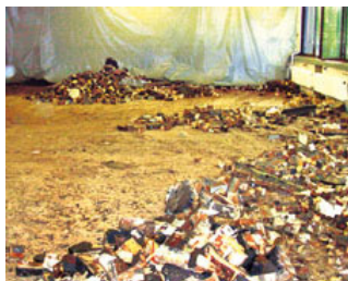
Entfernen des alten Bodenbelags
