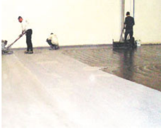
Auftragen der Versiegelung
