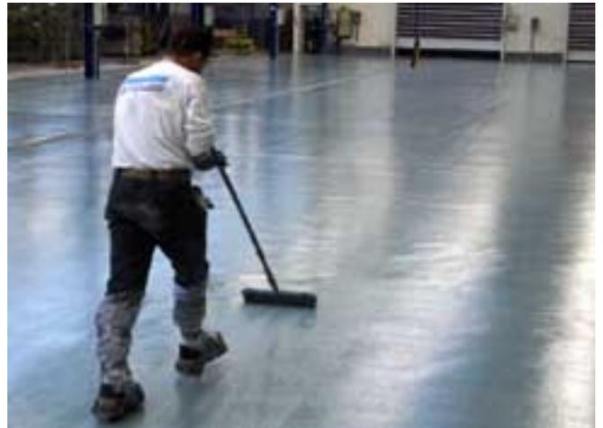
Epoxidestrich Stonset TG5 ersetzt werden. Als Beschichtungssystem wurde Stonhard Stonclad GS gewählt. Dabei handelt es sich um einen durchgefärbten Epoxidmörtel-Belag, der extrem belastbar ist (69 N/mm<sup>2</sup>).
