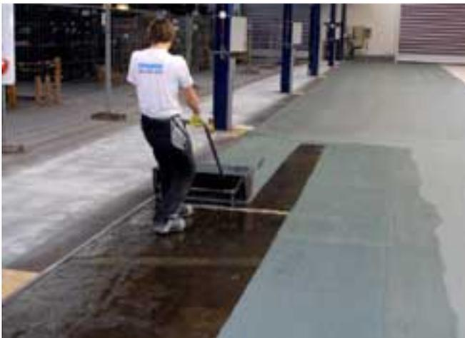
Der Untergrund bestand aus einer Betonplatte mit Estrich. Kritisch war die Güte der Betonsohle, da eine Nutzungsänderung der Halle geplant war und sich die Lasteneinwirkung dadurch erhöhte. Ein Sachverständiger entnahm deshalb zunächst Kernbohrungen, die im Labor auf ihre Druckfestigkeit
