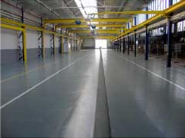
Abschließend wurden Fuß- und Fahrwege eingemessen. Diese Bereiche wurden ebenfalls mit Stonkote GS4 in den Farben verkehrsweiß und sicherheitsgelb gekennzeichnet. Aufgrund ihrer guten Erfahrungen hat Claas zwischenzeitlich die Ausführung weiterer 4.500 m<sup>2</sup> Fläche an Stonhard beauftragt.
